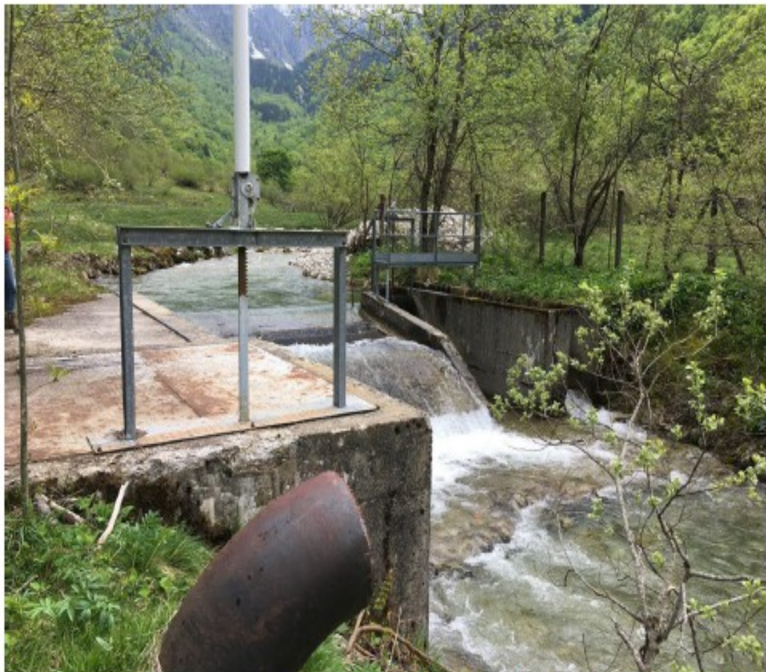
Photo 4 : Prise d'eau du Garbet vue depuis l'aval en rive droite
