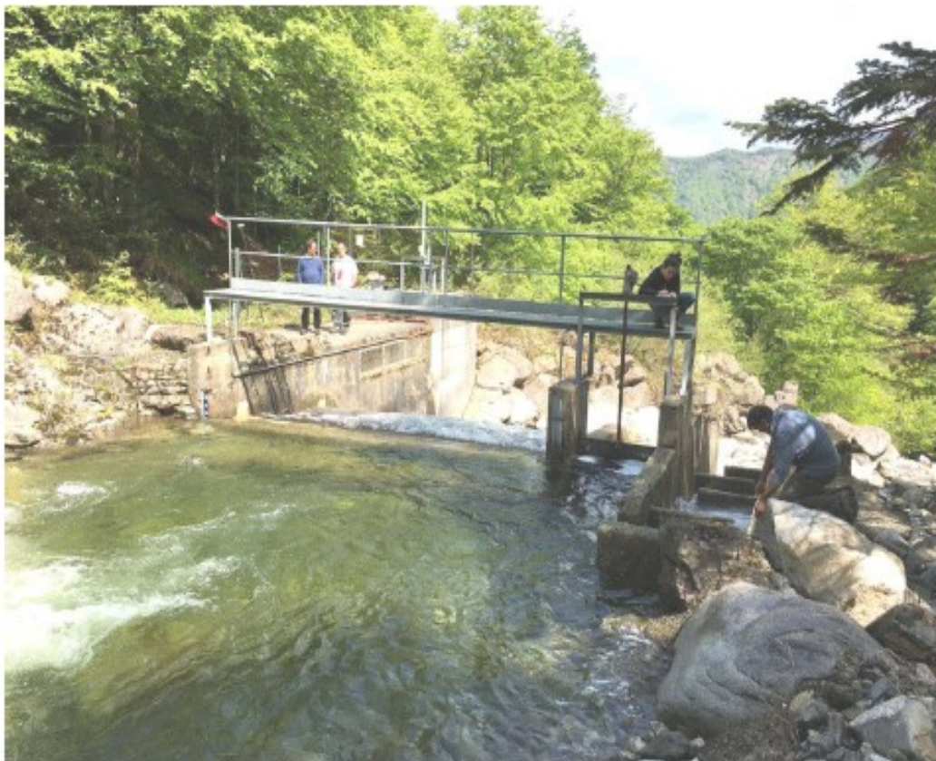
Photo 2 : Prise d'eau de l'Ars vue depuis l'amont en rive droite
